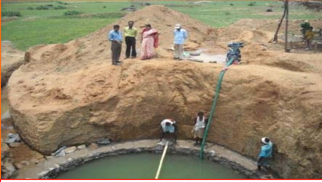
बरबेचवा टोला में माईक्रोलिफ्ट इरिगेशन योजना के तहत 20 फीट व्यास का निर्माणाधीन कूप
